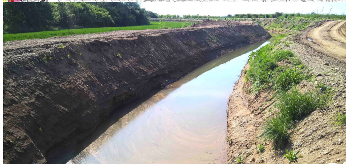
Construcțiile la minihidrocentrala de la Kusić au fost demarate
